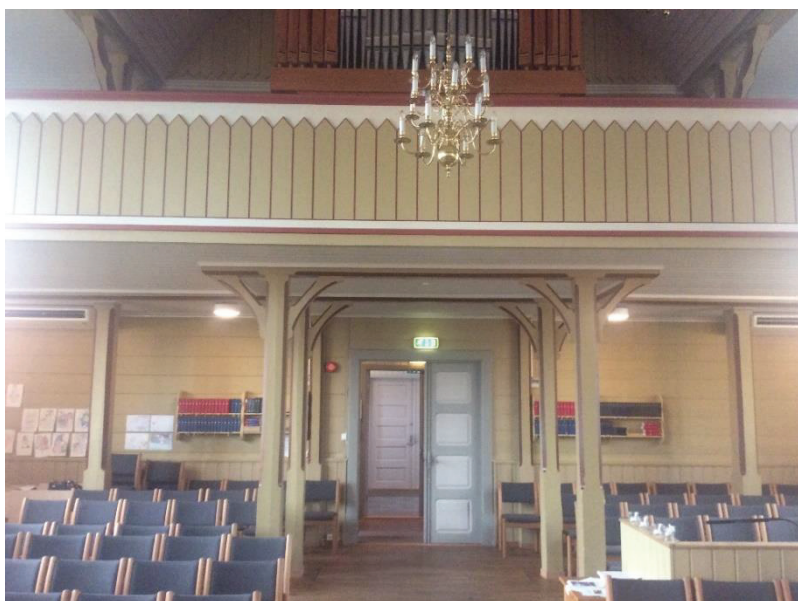
Foto: John Morten Espevik. Bilde viser søyler etc under orgelet
